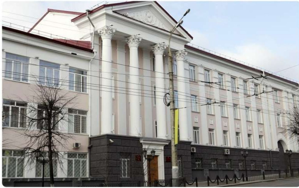
Реставрация фасада административного здания г.Ижевск ул. Пушкинская, 187
