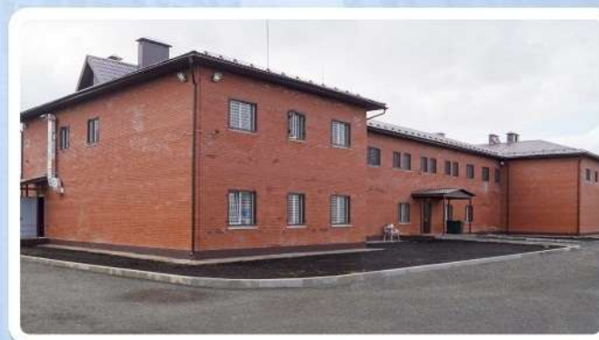
Здание изолятора временного содержания ОВД в п. Ува
