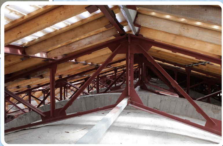
Кровля Благовещенского Собора. г.Воткинск
