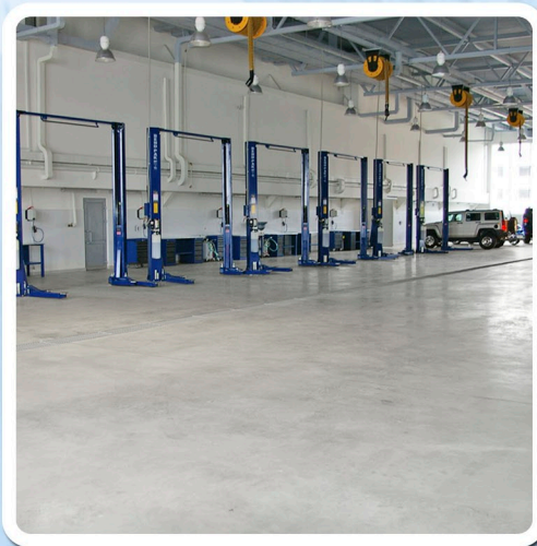
Упрочненный пол на территории станции технического обслуживания автосалона KIA - ТТС. г.Ижевск
